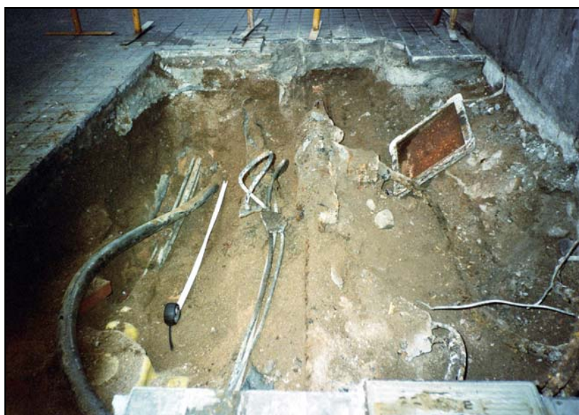
Foto 4: Detall del sondeig 400 on s'han localitzat nombrosos serveis.
