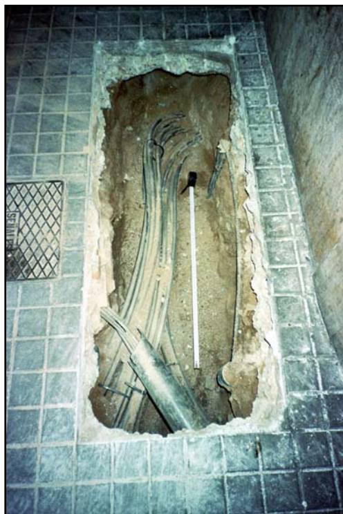
Foto 2: Detall del tram 300 de la rasa.
