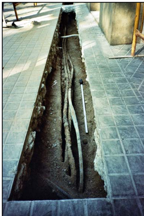
Foto 1: Detall del tram 100 de la rasa
