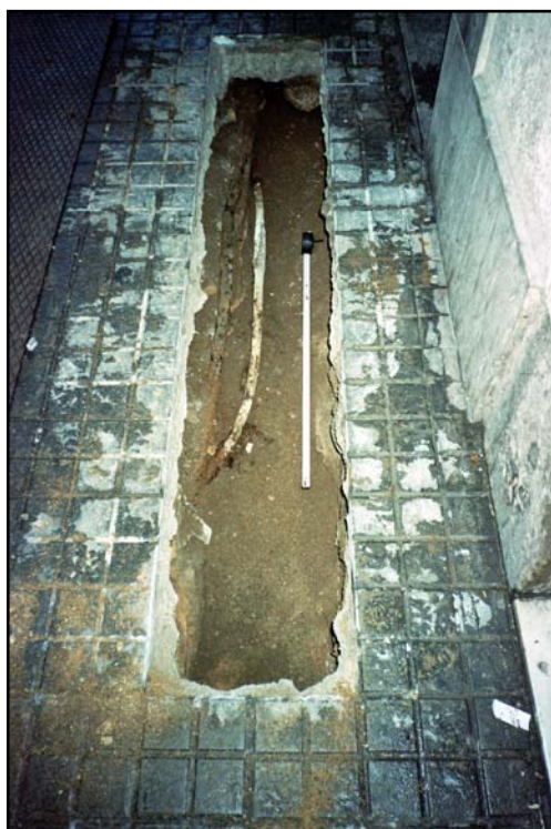
Foto 3: Detall del tram 200 de la rasa.
